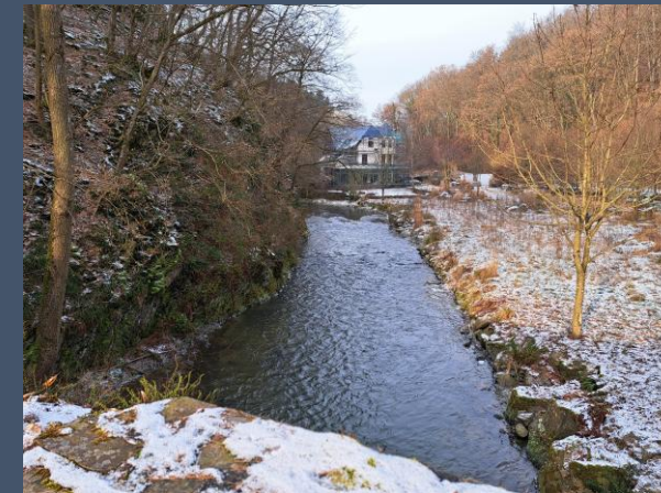
Nettequerung an der Hammesmühle
